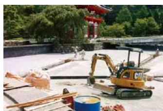
池の設計・施工も手掛ける
