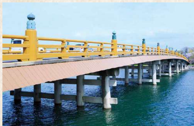
1979年に架替工事が行われた現在の瀬田の唐橋
