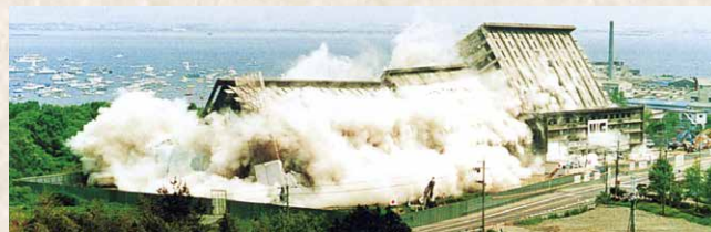
幽霊ビルの爆破解体
