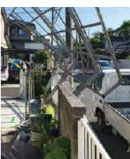
壊れたカーポートの撤去
